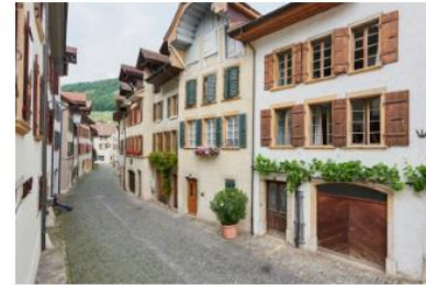
REBARBEITERHAUS TWANN BE
