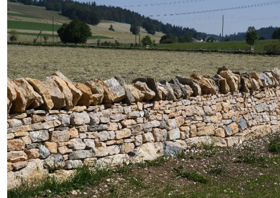
Murs de pierres sèches
